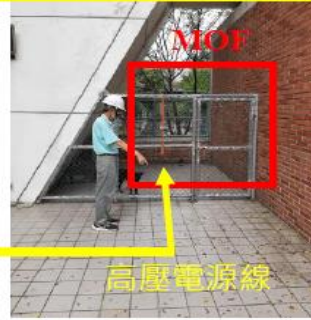
水塔建築 1 樓半露天區域
