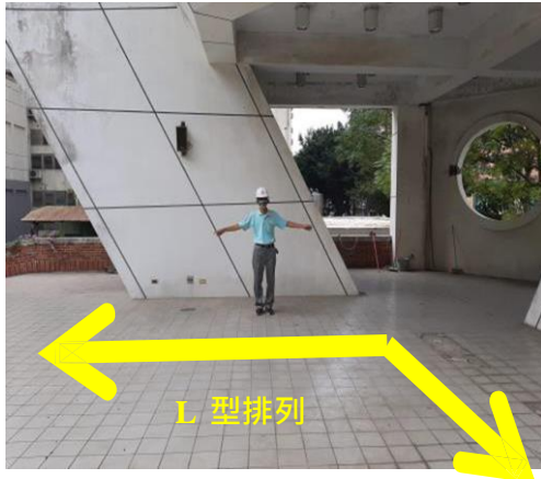
圖.1-2 於水塔建築半露天區域內，高壓盤擬採用L型排列方式。
